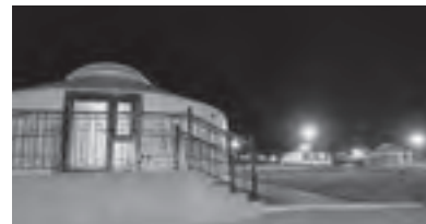
ゲルキャンプ 土台はコンクリでしっかりとした作り
